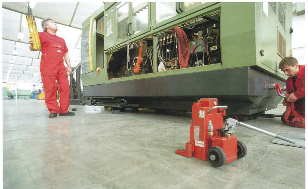
Das Foto zeigt das Anbringen der Anschlagmittel für das anschließende Positionieren mit dem beim Kunden vorhandenen Hallenkran.
