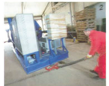
Quertransport im Gebäudeinneren auf Transportfahrwerken.
