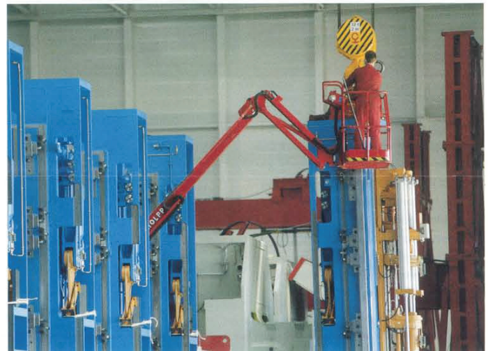
Der mit Gurten gesicherte Mitarbeiter gibt dem Kranführer Anweisungen, wie der Rauchgaskanal während der Demontage sicher aus der Anlage herauszuheben ist.
