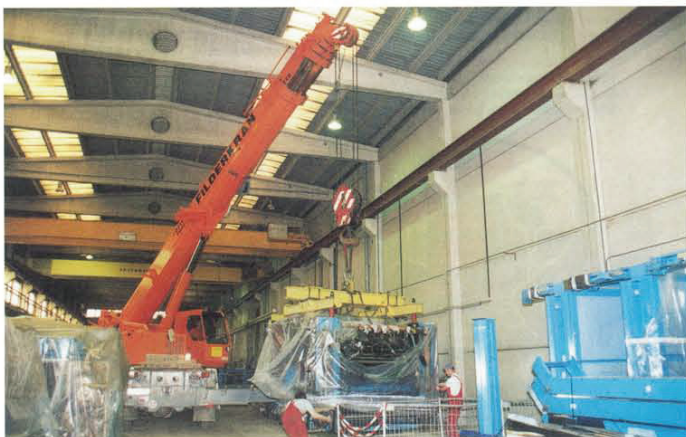
Zur Einlagerung wurden die angelieferten Druckeinheiten mit dem Autokran entladen und auf dem dafür vorgesehenen Platz abgesetzt.
