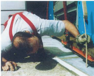
Ausmessen und Austarieren des Luftkissens während des Transports.
