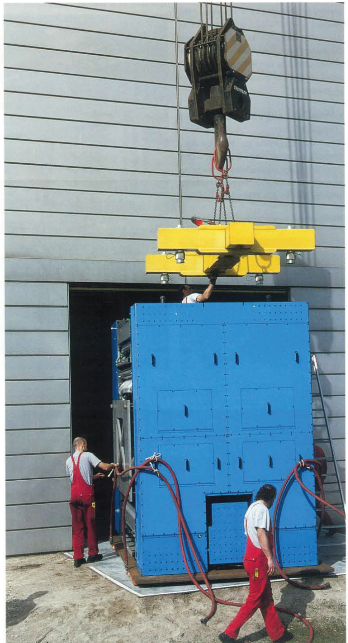
Nur durch den Einsatz von Luftkissentechnik unter der Transportplatte konnte die benötigte Transporthöhe für Ein- und Durchfahrt realisiert werden.
