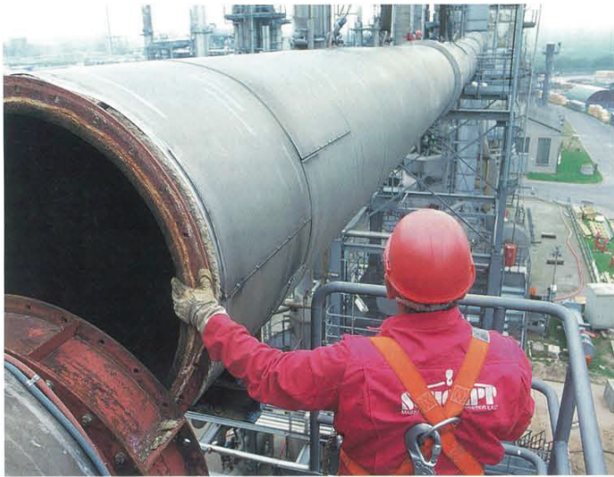
Der mit Gurten gesicherte Mitarbeiter gibt dem Kranführer Anweisungen, wie der Rauchgaskanal während der Demontage sicher aus der Anlage herauszuheben ist.
