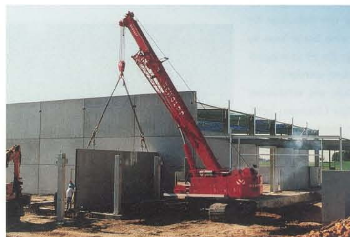
Betonfertigteilmontage mit RK 60.
