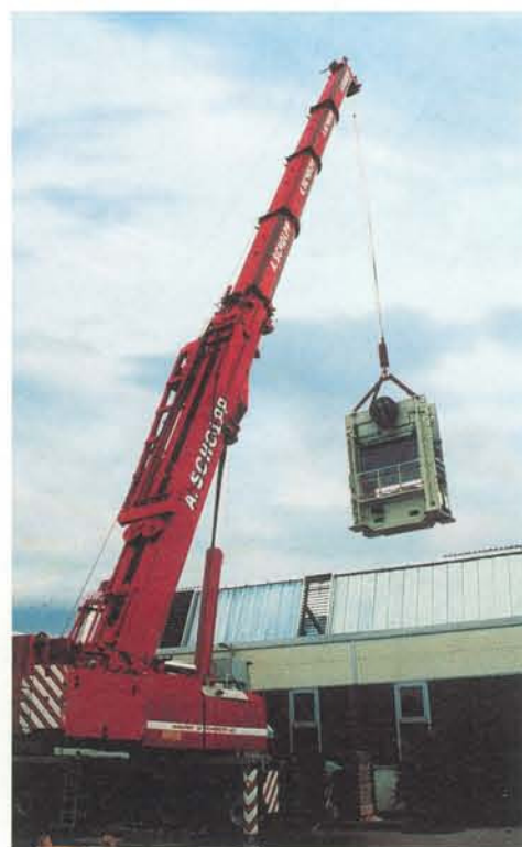
Der HK 300 beim Einheben der Presse.
