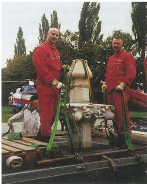
Die SCHOLPP-Mitarbeiter Tietze und Thieme vom Service-Point Dresden bei den Vorbereitungsarbeiten.
