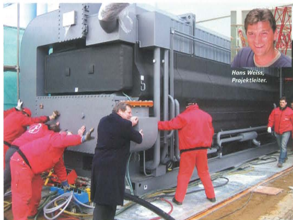
Mit Luftfilmtechnik werden 40 Tonnen fast »müelos« bewegt.
