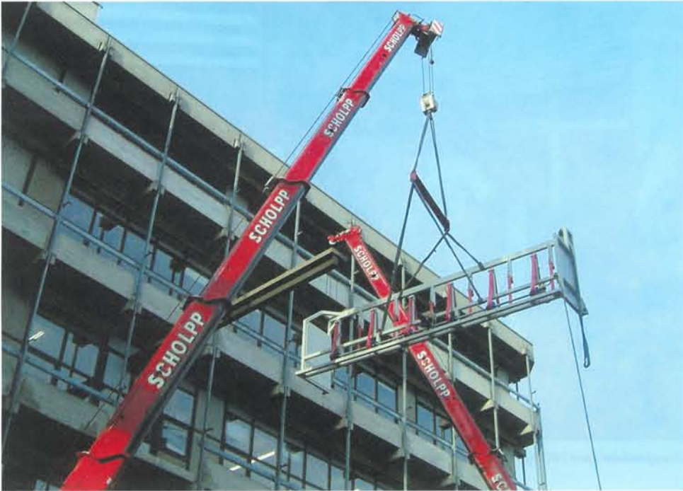
Einbringung der Rohrbündeleinheit.
