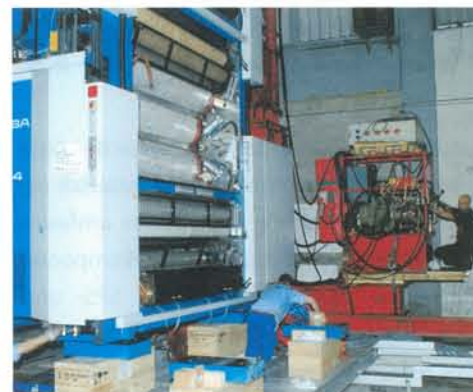
Das Montage-Team des SCHOLPP Kompetenz-Centers Print & Pack musste beim Schlusspurt des RCS-Großprojektes in Italien alle Register seines Könnens ziehen um einen unverrückbaren Termin sicherzustellen.
