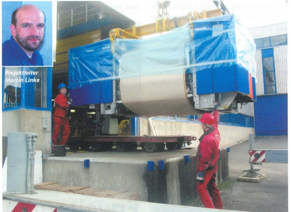
Die Einbringung der neuen WIFAG evolution 371-Achtertürme durch SCHOLPP bei Ouest France fand unter hohem Zeitdruck und schwierigsten Bedingungen statt.
