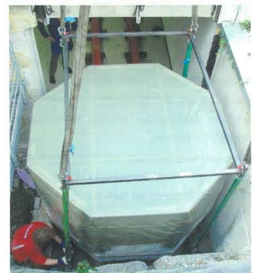
Das Einbringen von neun Montagezellen mit je 3,5 Tonnen Gewicht erfolgte durch einen schmalen Schacht.
