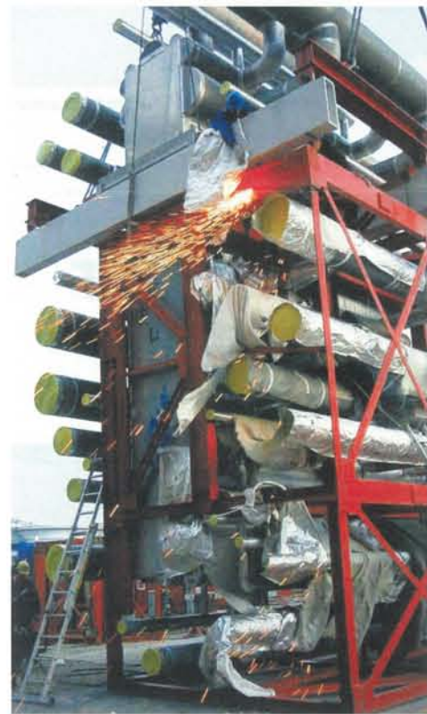
Zuerst mussten die Transportversteifungen demontiert werden.
