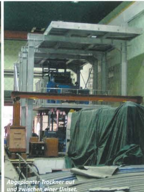
Maßarbeit beim Einbringen des 9,3 m langen Trockners bei 9 m Gebäudeabstand.
