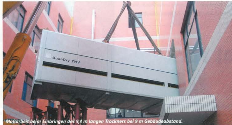
Maßarbeit beim Einbringen des 9,3 m langen Trockners bei 9 m Gebäudeabstand.
