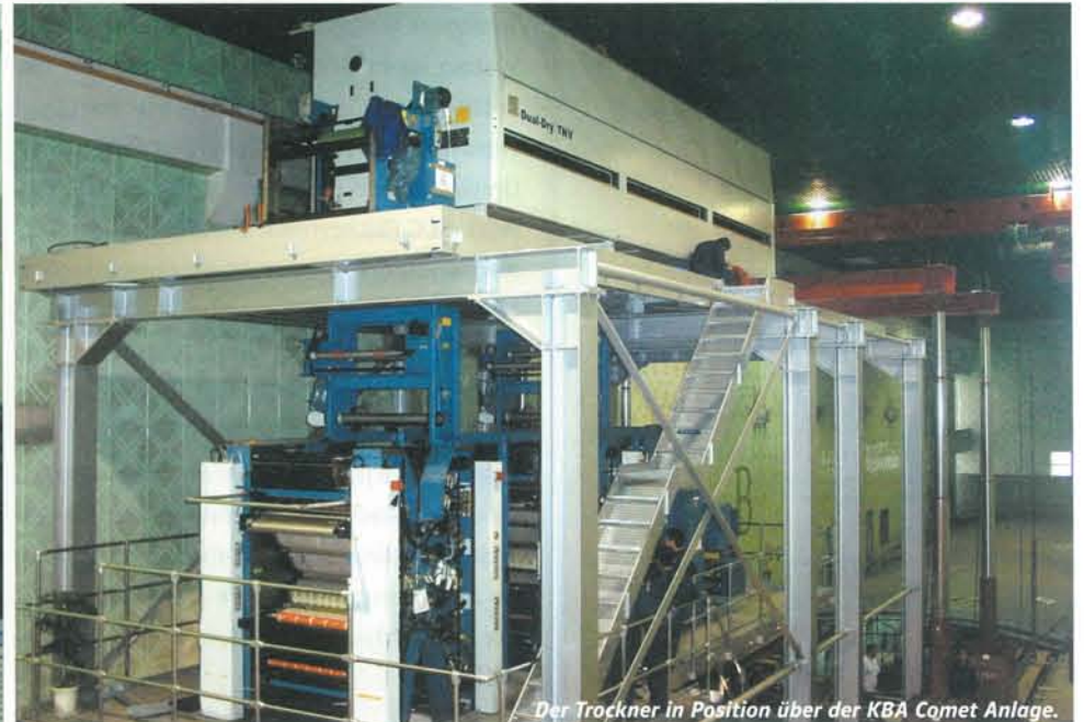
Der Trockner in Position über der KBA Comet Anlage.
