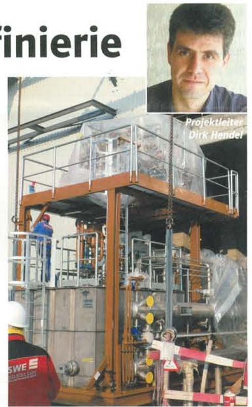
Einbringung der Öleinheit für die Ethylenanlage der OMV-Raffinerie in Wien.
