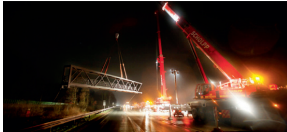
Zwei SCHOLPP-Krane setzen im Zusammenspiel die 54 m lange Schilderbrücke in Position
