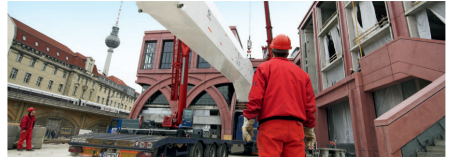
Bei Alexa in Berlin hat SCHOLPP 10 Fahrtreppen unter engsten Raumverhältnissen eingebracht
