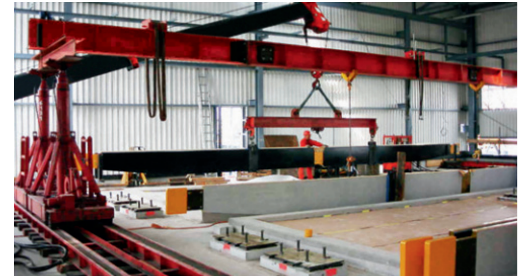
Präzises Aufsetzen des Elektrolyzers
