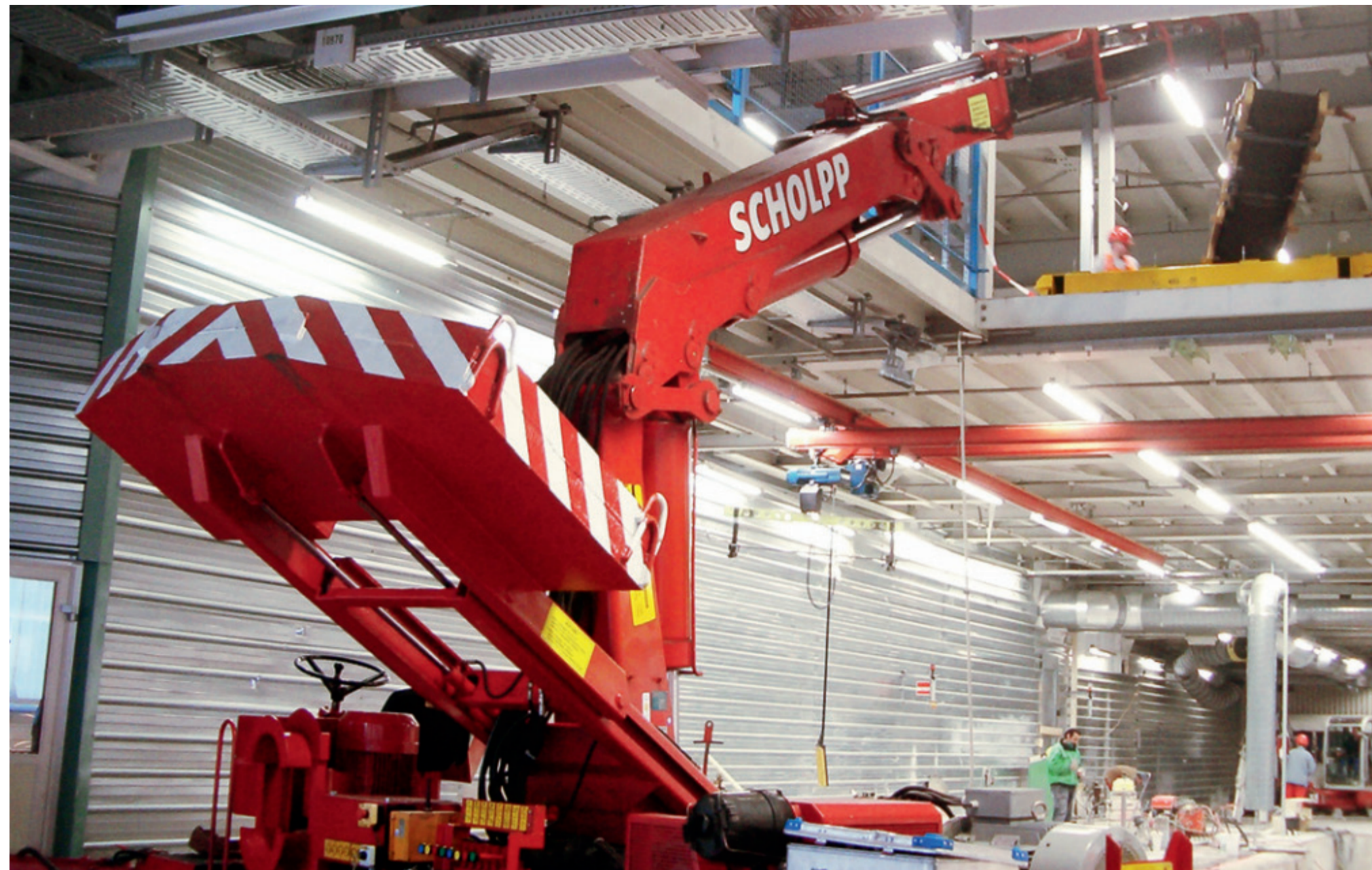
Seit Jahren ist SCHOLPP mit seinem speziellen Rückbau-Know-how ein fester Dienstleister
