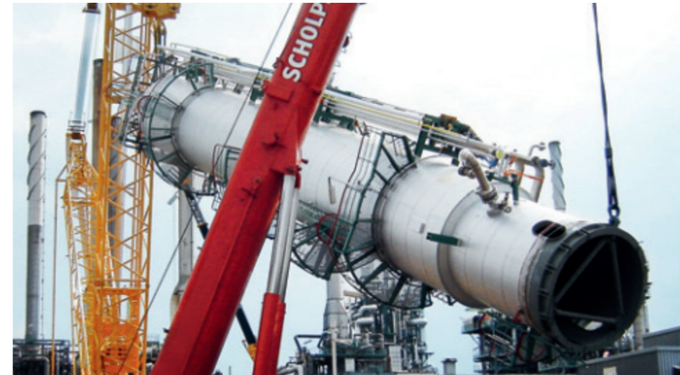
300 Tonnen werden aufgerichtet
