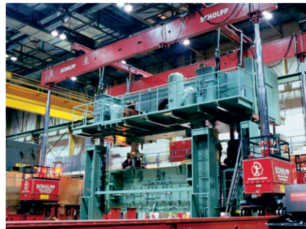
Das größte Hubgerüst bei SCHOLPP: das TG 1000 beim Setzen eines Pressenkopfes mit 300 t
