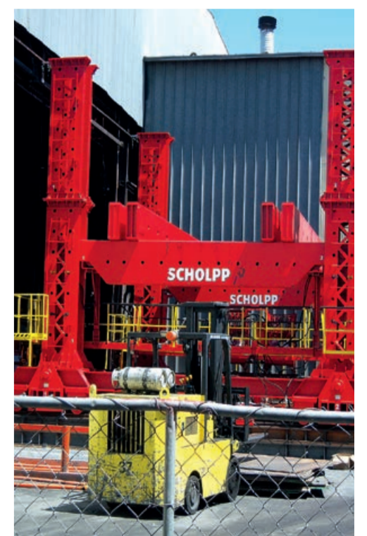
Das vormontierte Hubgerüst ist aufnahmebereit
