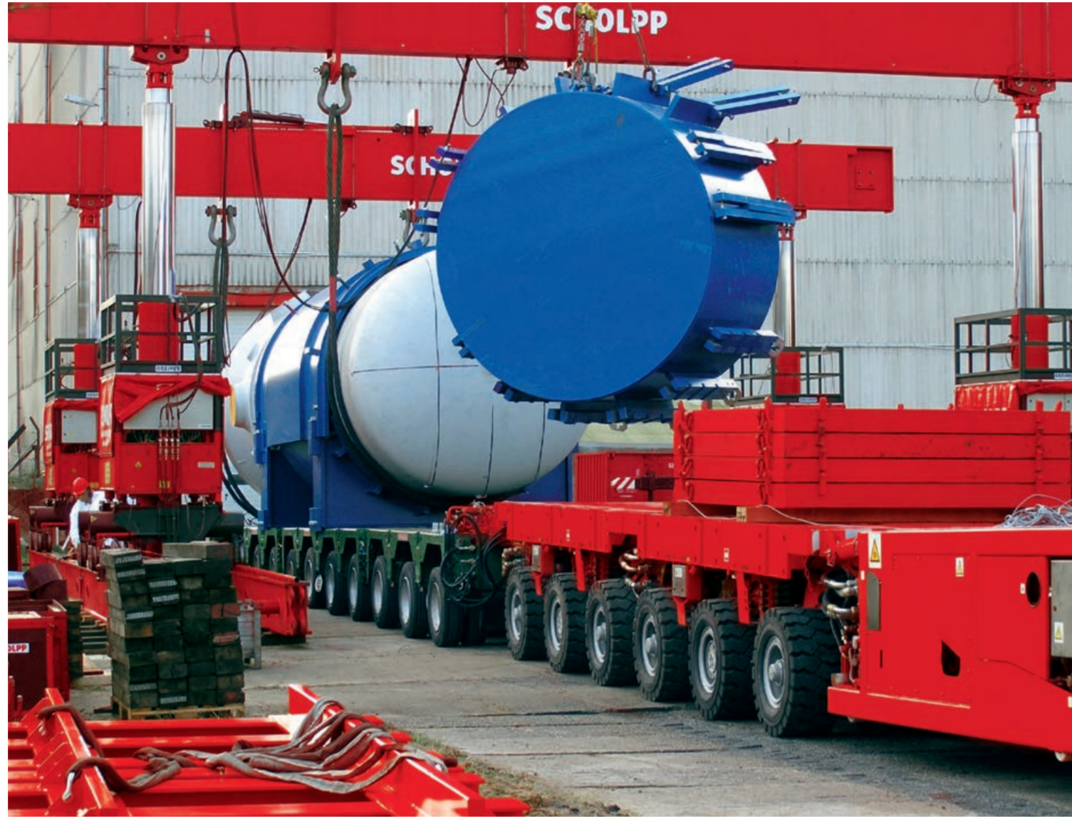
Montage der Strahlenschutzabschirmung auf der Kalottenseite des Reaktor-druckbehälters
