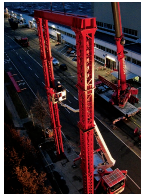
Riesige Stützen überwinden die Höhe, dahinter fahren die Container leer nach oben und mit Abbaumaterial gefüllt nach unten
