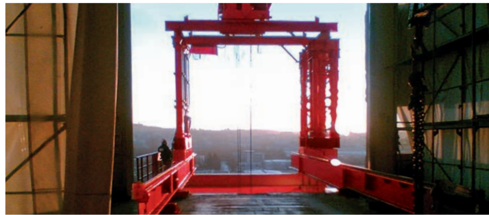
Insgesamt führt SCHOLPP den Rückbau mit 330 Mitarbeitern, Tag- und Nachtschicht in 30 Tagen durch. Dabei hat SCHOLPP ein Hubgerüst mit einer max. Hakenhöhe von rund 24 m im Einsatz. Ein Hubgerüst mit dieser Höhe ist auch bei SCHOLPP nicht alltäglich und stellt eine besondere Herausforderung an die Statik, den Aufbau und die Bedienung dar
