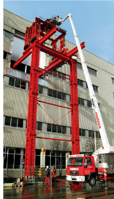
Insgesamt führt SCHOLPP den Rückbau mit 330 Mitarbeitern, Tag- und Nachtschicht in 30 Tagen durch. Dabei hat SCHOLPP ein Hubgerüst mit einer max. Hakenhöhe von rund 24 m im Einsatz. Ein Hubgerüst mit dieser Höhe ist auch bei SCHOLPP nicht alltäglich und stellt eine besondere Herausforderung an die Statik, den Aufbau und die Bedienung dar
