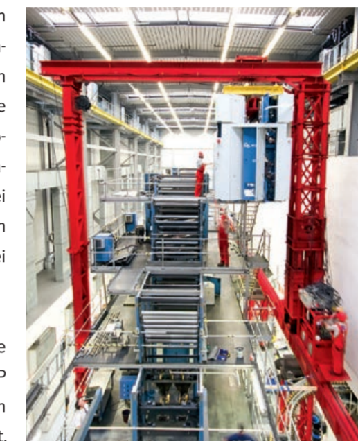
Die Druckeinheit muss an der produzierenden Anlage vorbei zur vorgesehenen Position gebracht werden
