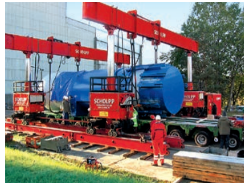
Umsetzen des Reaktor-druckbehälters auf den Transportwaggon
