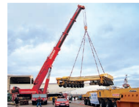
Die nicht alltäglichen Fahrzeugmaße: 20 Meter lang, 10 Meter breit, 6 Meter hoch
