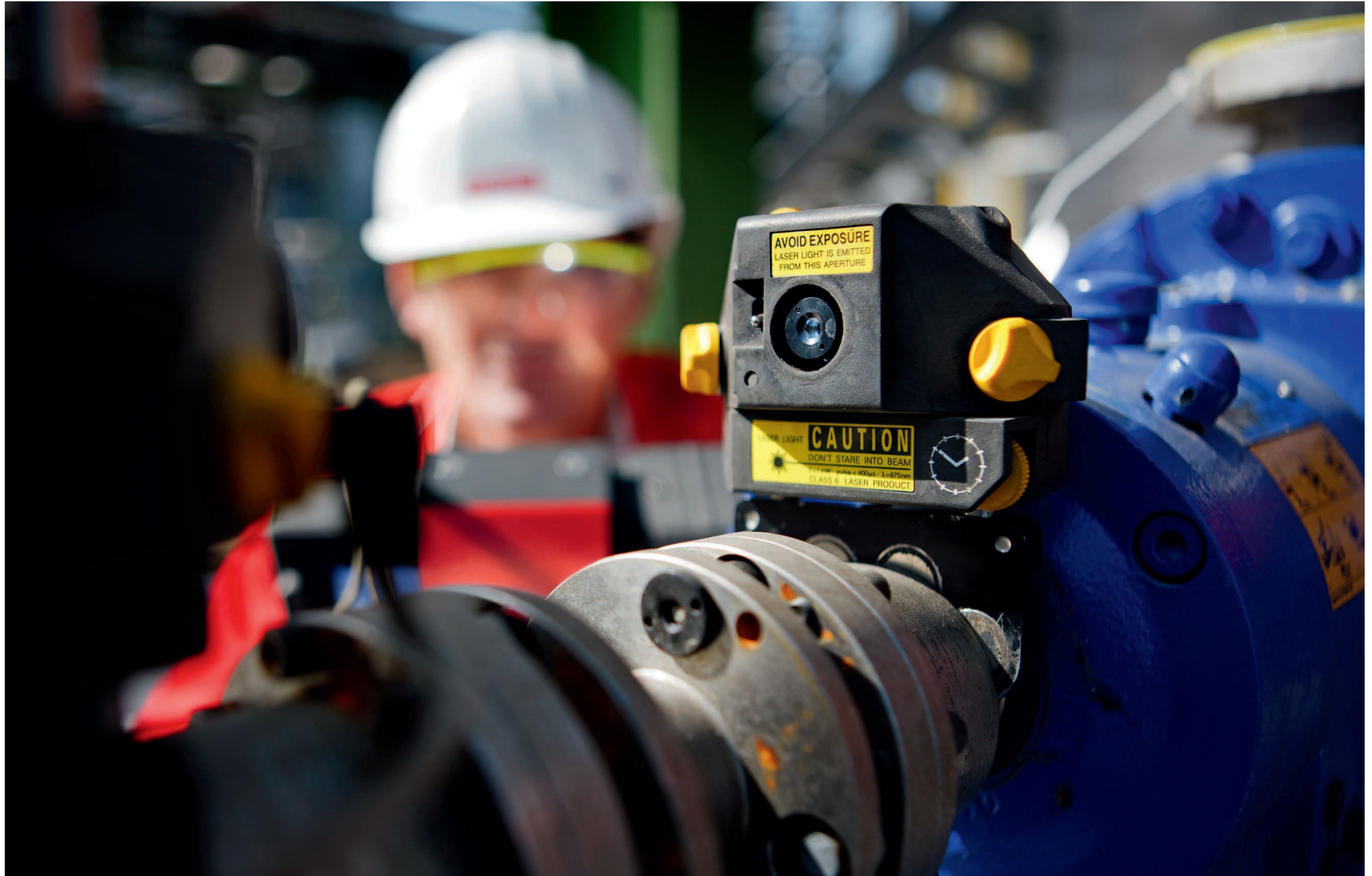
SCHOLPP für BIS im Werk Shell Wesseling der Rheinland Raffinerie: präzises Ausrichten von Pumpen, inklusive Vermessung und Feinausrichtung mit dem laseroptischen Ausrichtsystem Rotalign.
