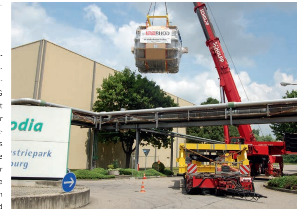
SCHOLPP für Rhodia: Einbringung einer 50 Tonnen schweren Acetylierungstrommel in Freiburg.
