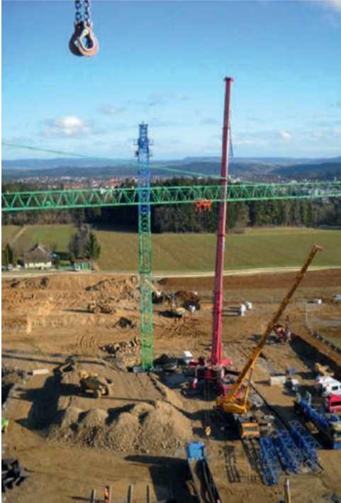
Neubau Schwarzwald-Baar-Klinikum, Villingen-Schwenningen
