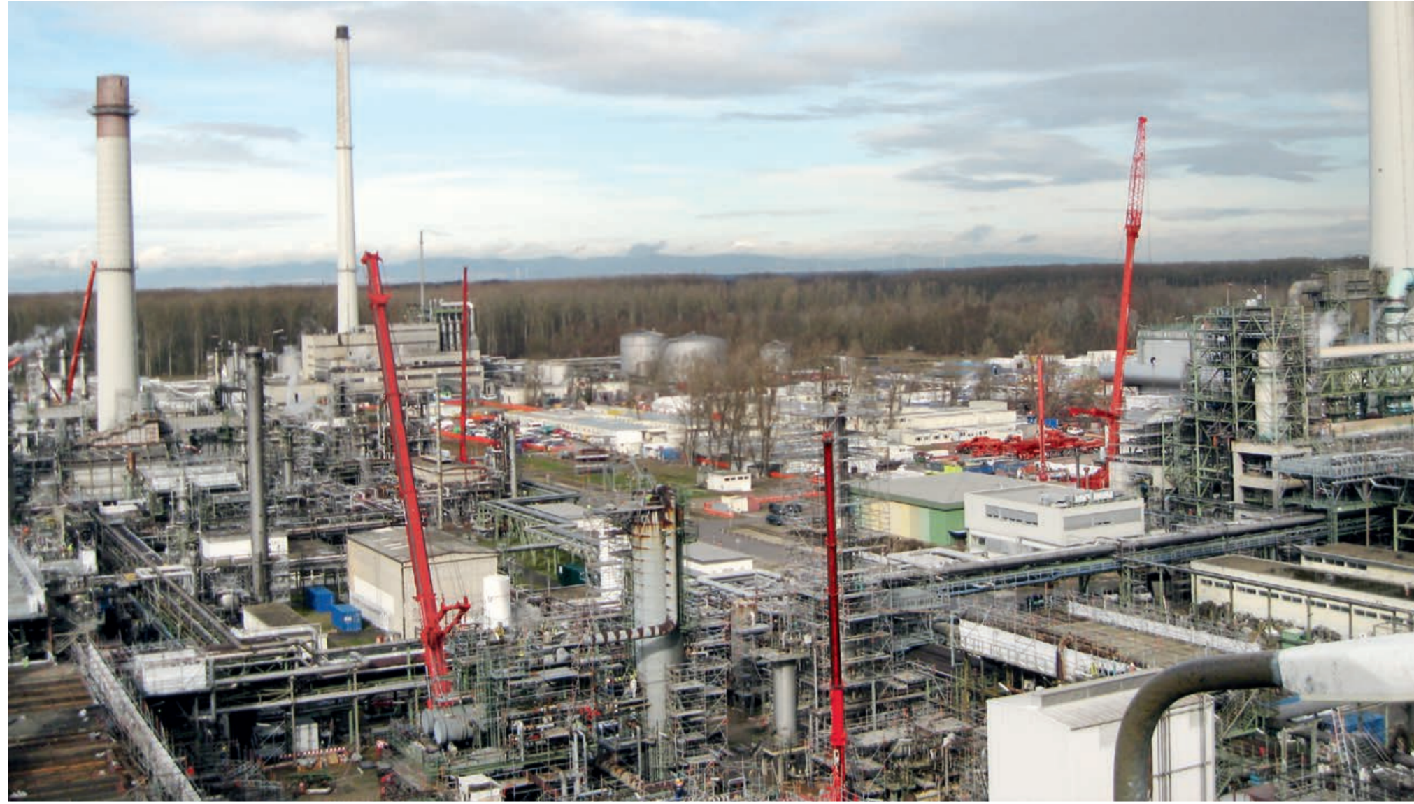
Während der sechswöchigen TÜV-Prüfung im MiRO Raffinerie-Werkteil zwischen Alb und Rhein waren insgesamt 34 Krane von SCHOLPP im Einsatz, um zum Beispiel Kolonnen, Behälter und Rohrbündel zu bewegen.
